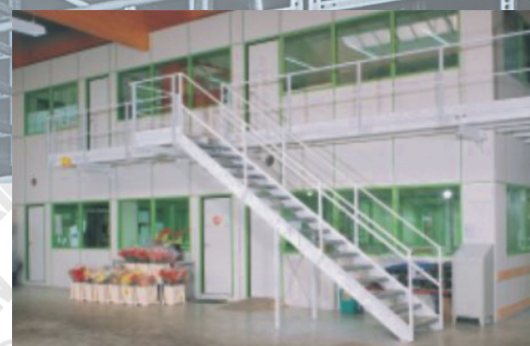
▲ Platforme metalice pentru optimizarea pe înălțime a spațiului
