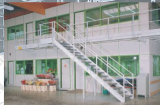
▲ Platforme metalice pentru optimizarea pe înălțime a spațiului
